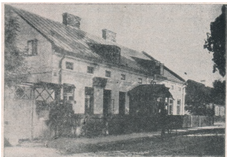
Šaltinio spaustuvės namai prieš remontą
