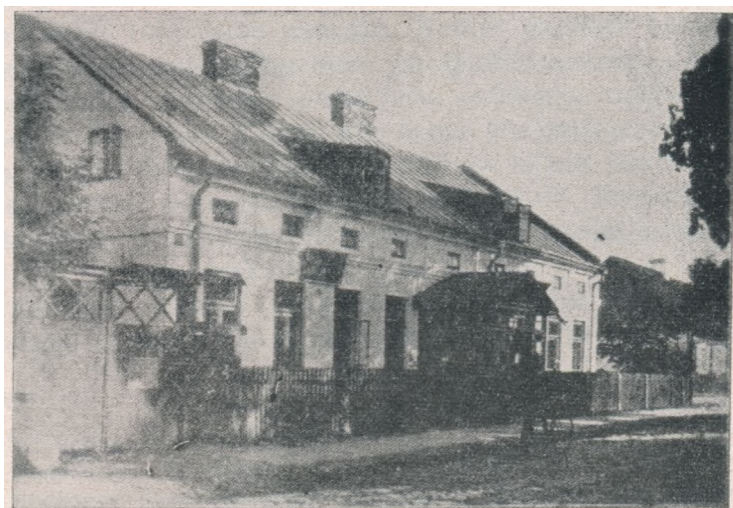
Šaltinio spaustuvės namai prieš remontą
