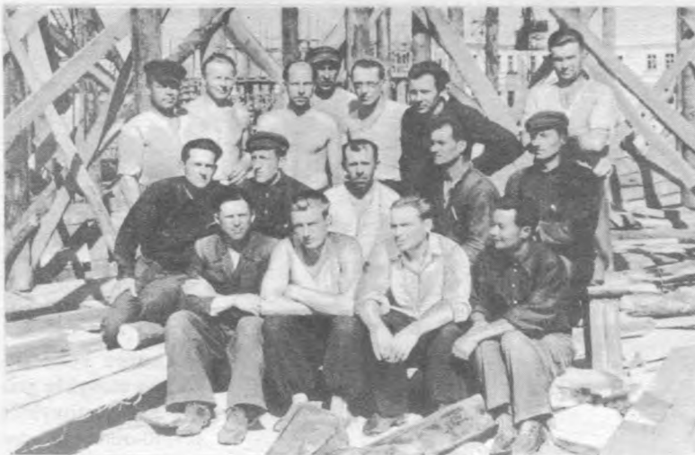
Vorkuta. 53-oji kalinių brigada 32-osios anglių šachtos statyboje (1955)
