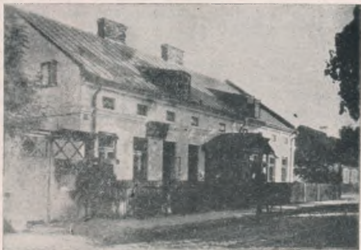
Šaltinio spaustuvės namai prieš remontą
